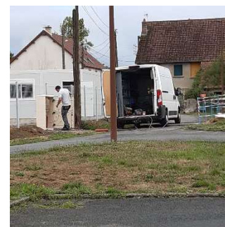
Travaux électriques le 01/06 matin
